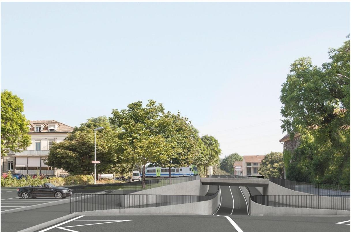
Bahnunterführung Spital: Die neue Unterführung ermöglicht ein niveaufreies Kreuzen von Bahn und Strasse und eliminiert damit die bisherigen Wartezeiten bei geschlossenen Barrieren.
